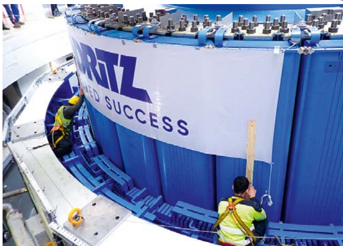
水力発電設備A-1ピットへの発電機回転子の設置
