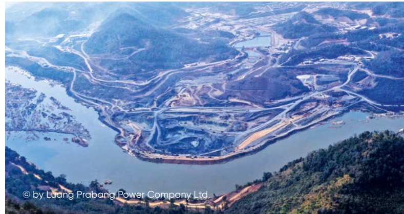
ルアンパバーンの建設現場の外観
