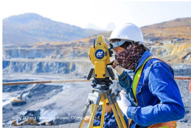
土木工事開始時の河川堤防での測量作業
