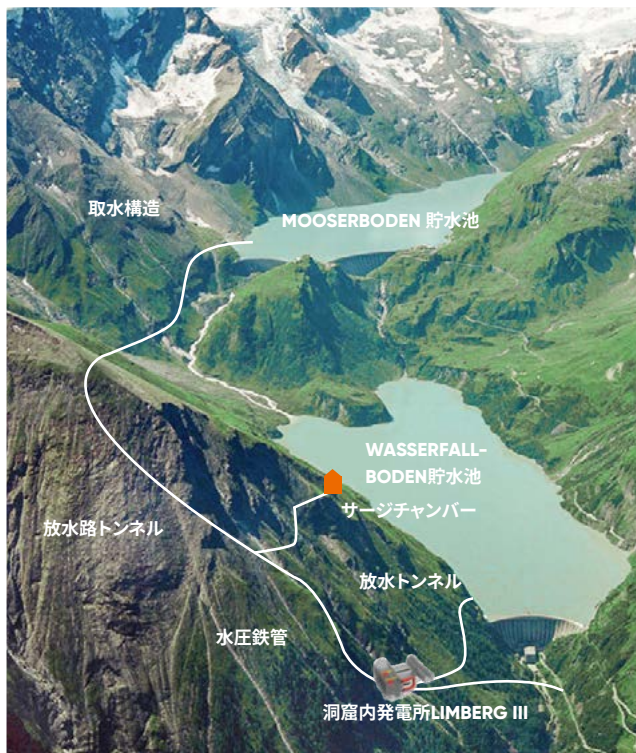
VERBUND社が所有および運転するLimberg 3発電所の方式
