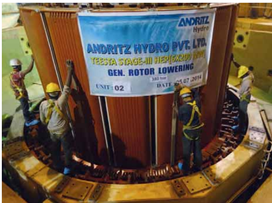
Rebaixamento do rotor na unidade 2
