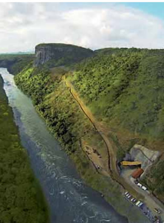
▣ Rio Kwanza e futuro acesso à casa de força da UHE de Laúca
