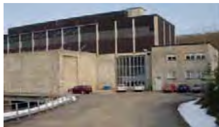
▣ Usina de Bjurfors Nedre
