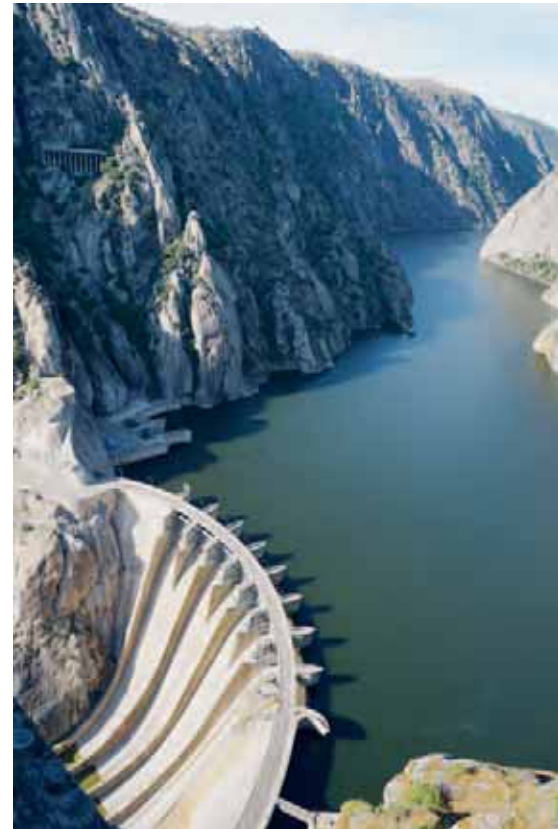
▣ Vista do reservatório a partir da casa de controle
