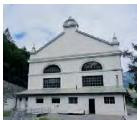
□ Casa de força
