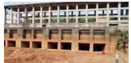
A usina hidrelétrica de hoje
