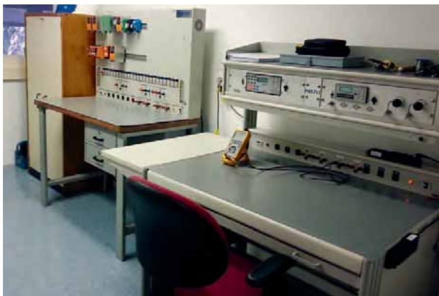
Bancadas de ensaio para instrumentação, PLCs e redes de comunicação
