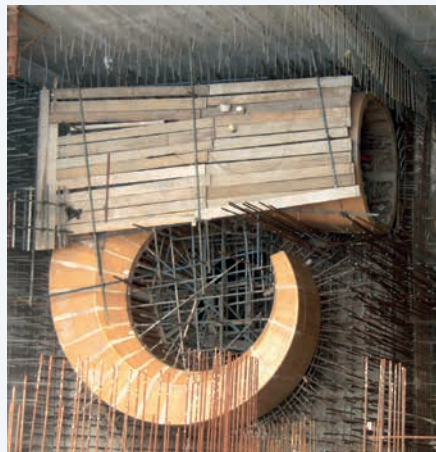
Betonguss vor Ort (In situ)
