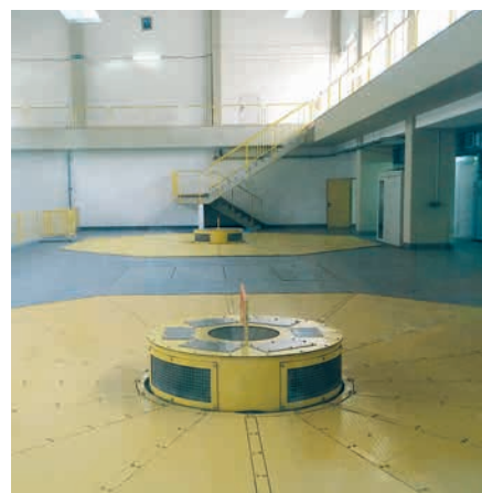
Maschinenhalle vor Modernisierung
