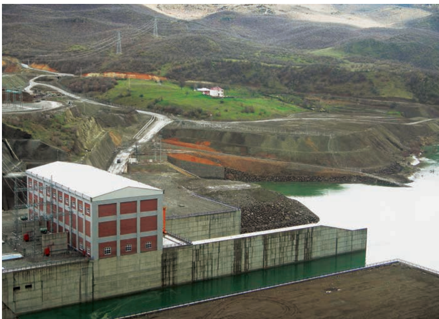
Blick auf die Kraftwerksanlage
